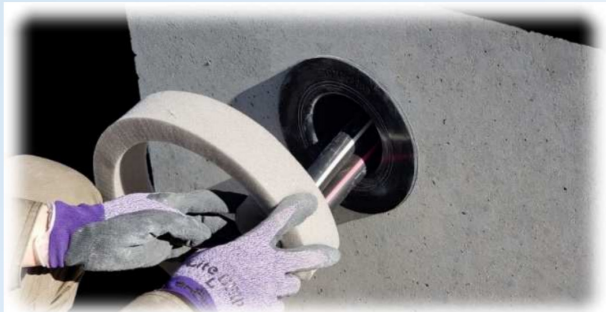
①すう太郎(バックアップ材)をケーブルに巻き付け。
