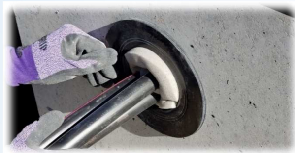
②ケーブル伝いに管路口奥側へ押込む。
