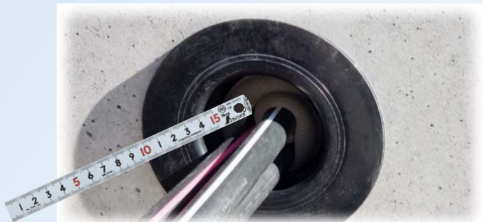
③とめ太郎充填厚目安を参考に計測、位置確定。
